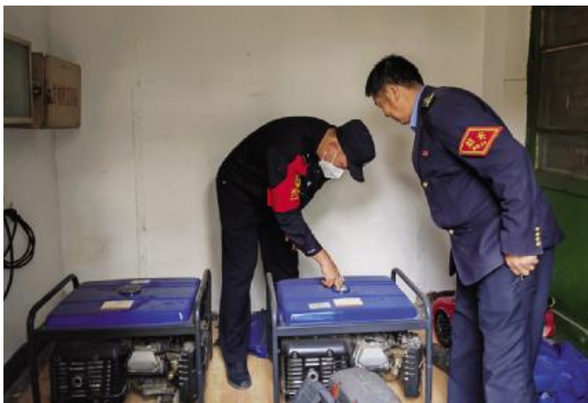
近日,通辽铁路公安处四合永车站派出所结合冬季防火工作,对辖区开展消防安全监督检查活动,压实铁路企业消防安全主体责任,确保冬季防火工作绝对安全。
