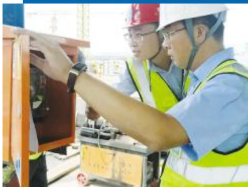
△ 复工安全检查。
